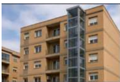
CURSO "ACCESIBILIDAD EN EDIFICIOS RESIDENCIALES: SOLUCIONES PRÁCTICAS SIN COSTES DESPROPORCIONADOS" 05/05/2025-19/05/2025 (20 h) Precio colegiados/as: 100 €
