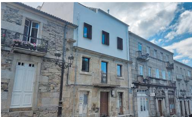
En el sector de la construcción cada vez tienen más peso en la zona las obras de rehabilitación.
