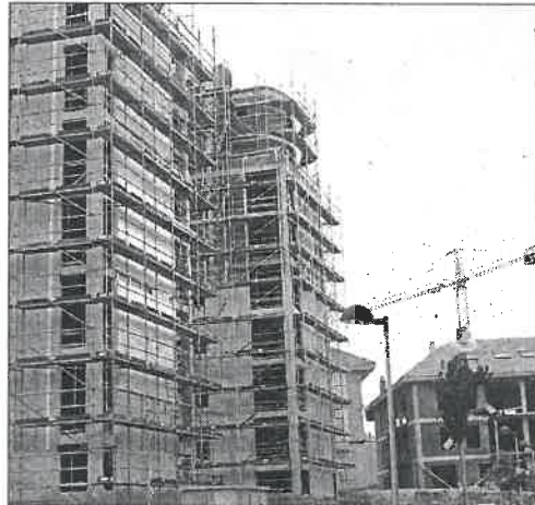
Dos edificios en construcción en Santiago.
