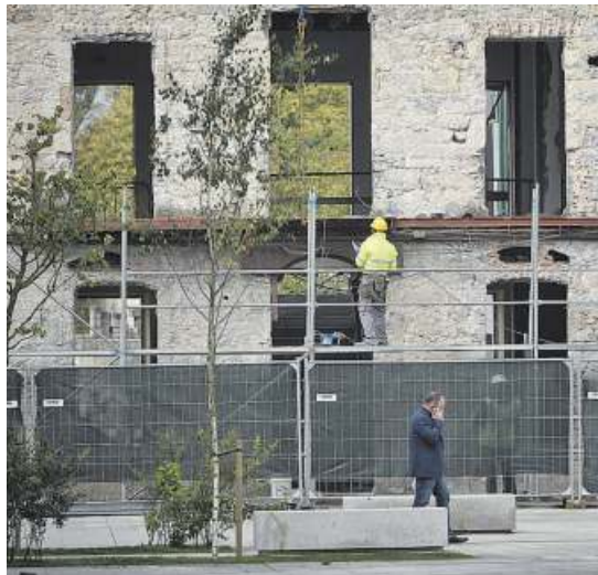
Imagen de las obras en el nuevo consistorio de Silleda. MIGUEL SOUTO
