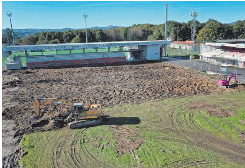
Imagen del inicio de las obras de destierre en el campo de hierba natural del Anxo Cortizo de Lalín.
