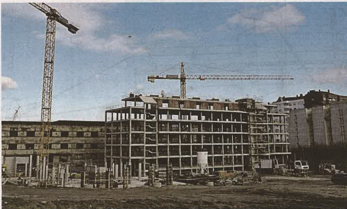
Una promoción de viviendas nuevas en construcción en la calle Tomás Alonso.
