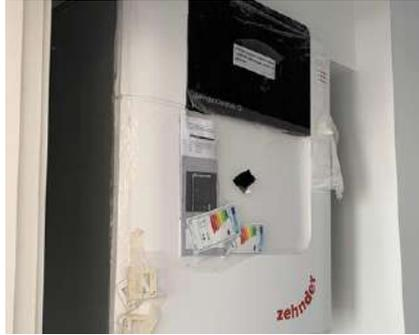
*Figura 11. Sistema de ventilación con recuperador de calor. Vivienda en Carrión de los Condes (Fuente: Medgón Passiv Haus)*
